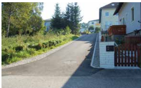
Teilstück Gemeindestraße „Schmiedfeld“
